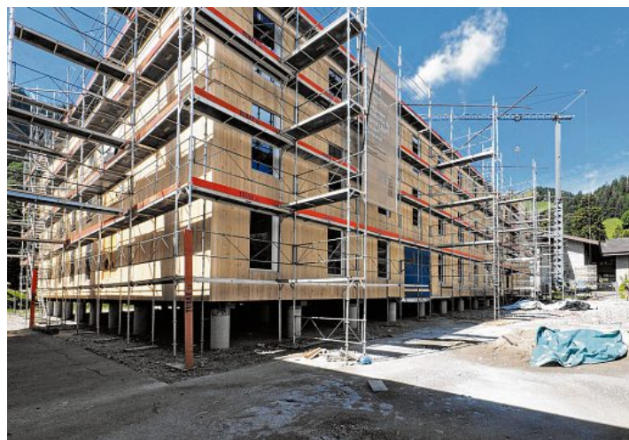
Das erste der zwei Holzgebäude wird Ende Jahr sicher fertig sein.
