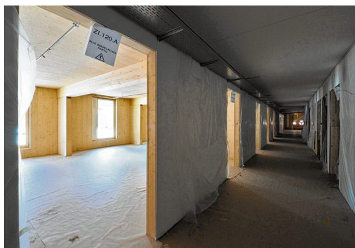
In jedem der Holzgebäude gibt es einen grossen Aufenthaltsraum.
